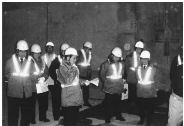
トンネル工事現場内部の視察
