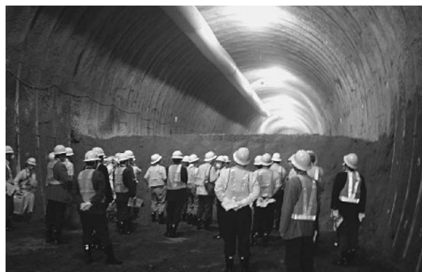
柴山トンネル掘削先端部見学
