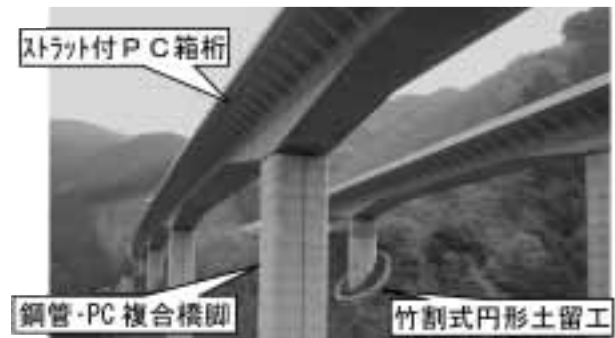
写真-1 芝川高架橋(棧台より)
