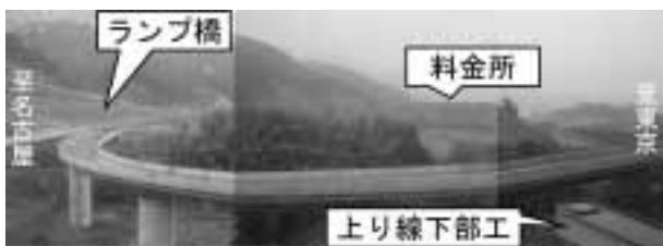
写真-3 清水IC（下り線本線橋より）
