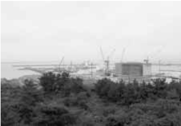
中央埠頭の建設状況（展望台より撮影）
