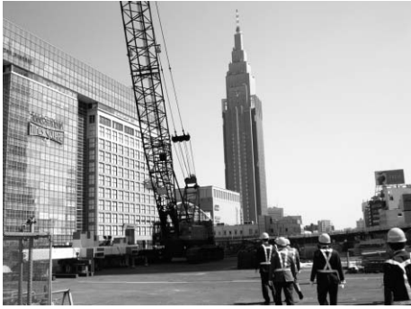
▲甲州街道南側の人工地盤建設現場
