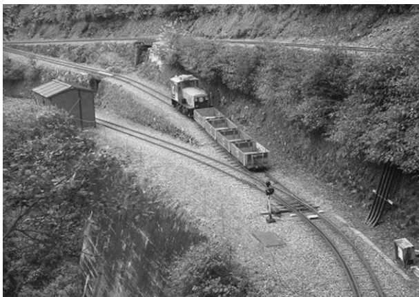
▲砂防工事専用軌道
