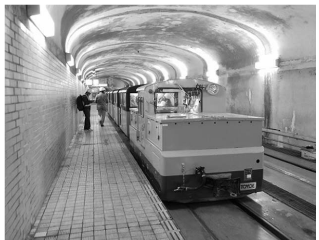
▲関西電力専用通路・上部軌道
