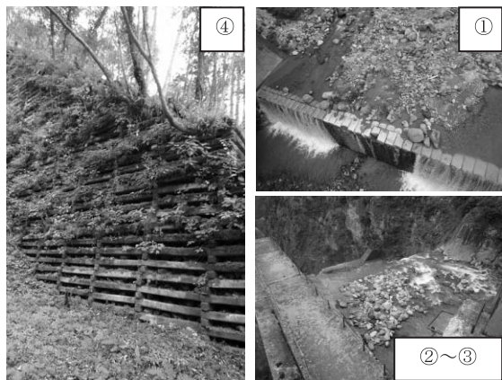
▲白岩砂防えん堤（重要文化財）
