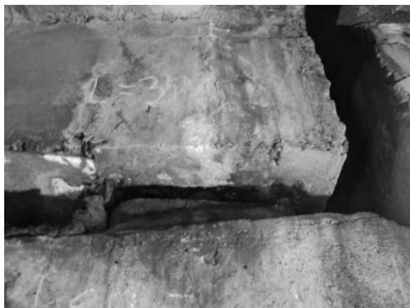
ゲルバー部の支承
